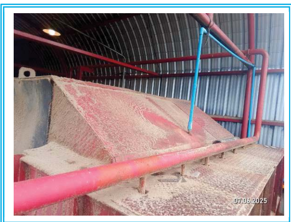
รูปที่ 3-6 ติดตั้งสปริงเกอร์ตลอดแนวสะพานยาง
