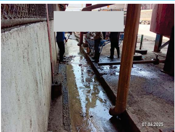
รูปที่ 3-23 ขุดลอกระบบระบายน้ำเป็นประจำ
